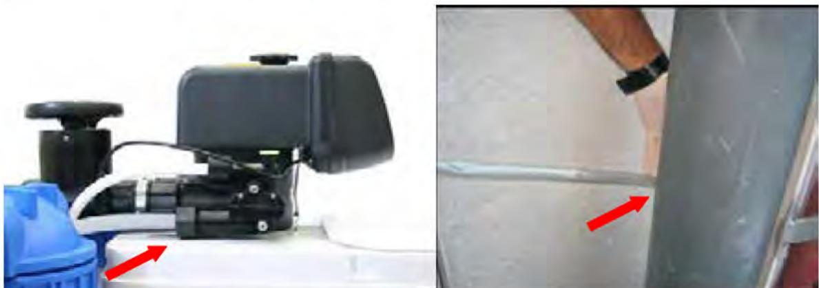
Coloque también un tubo desde la salida del rebosadero al desagüe (línea de drenaje), para evitar una posible inundación en caso de una programación incorrecta, o una fuga de agua por montaje inadecuado, o por un fallo de la válvula. El nivel de desagüe deberá estar por debajo de la salida al rebosadero (ver instalación desagüe).
