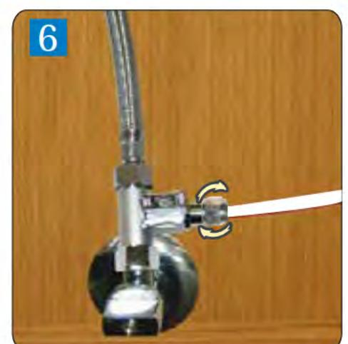
Conecte el tubo blanco desde la toma de agua fría, como se indica en los pasos anteriores, hasta la entrada de agua del equipo de Ultrafiltración.
