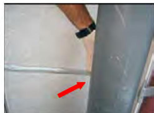
Coloque también un tubo desde la salida del rebosadero al desagüe (línea de drenaje), para evitar una posible inundación en caso de una programación incorrecta, o una fuga de agua por montaje inadecuado, o por un fallo de la válvula. El nivel de desagüe deberá estar por debajo de la salida al rebosadero (ver instalación desagüe).
